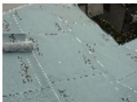
施工中 軽量ストレート瓦の上に重ね 断熱効果を高めます
